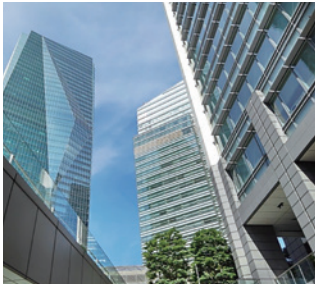
高層オフィスビル
