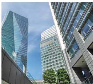
高層オフィスビル
