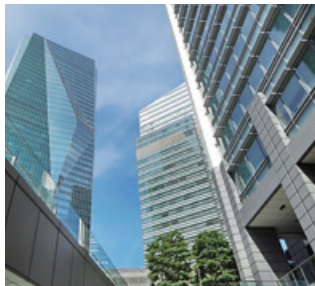
高層オフィスビル
